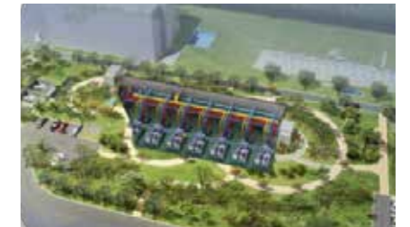
탄천 물재생센터 지역난방온수공급용 터보히트펌프
