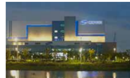
삼성바이오로직스 송도공장 프로세스용 터보냉동기
