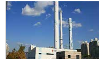
한국 지역 난방공사 용인지사 지역난방온수공급용 터보히트펌프
