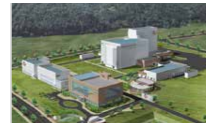
CJ헬스케어 오송공장(GMP) 프로세스용 터보냉동기
